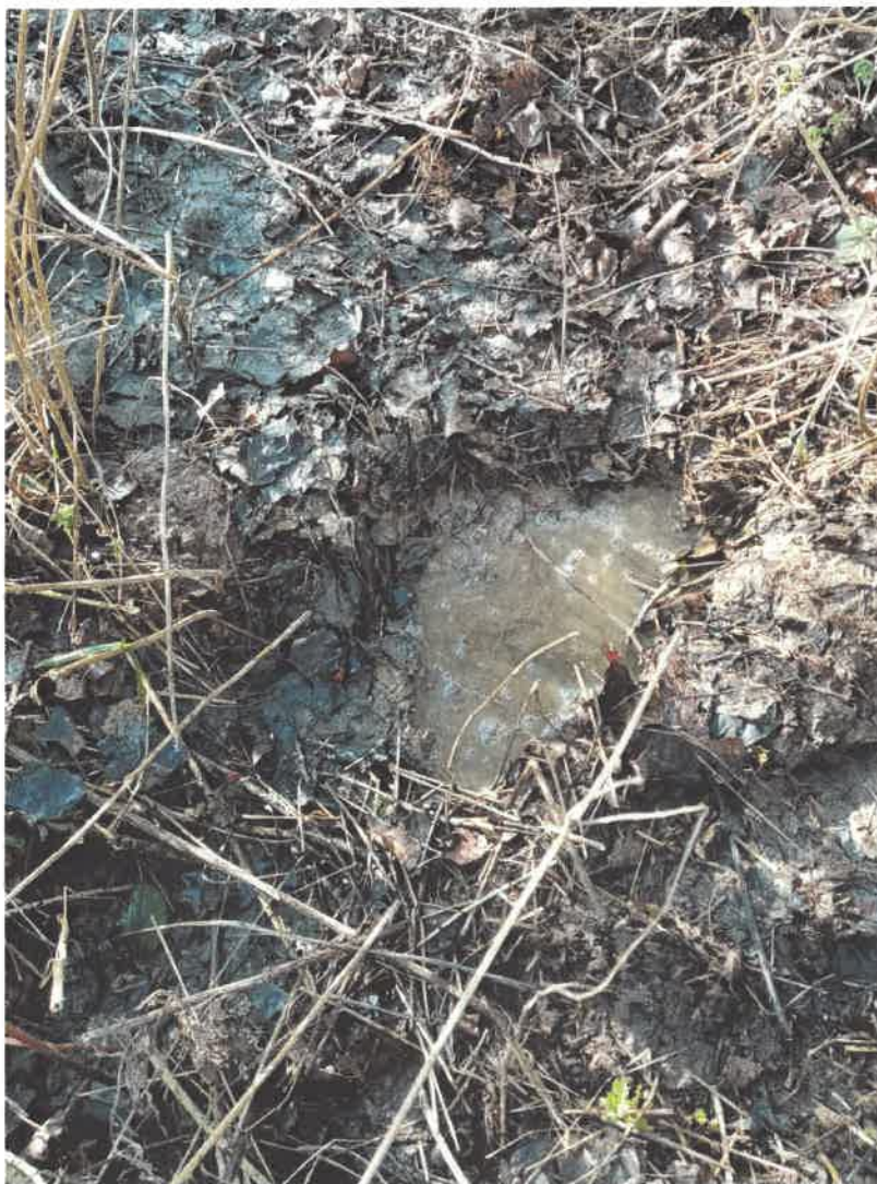
PHOTO 7 : regard d'évacuation des bassins de décantation - bouché
